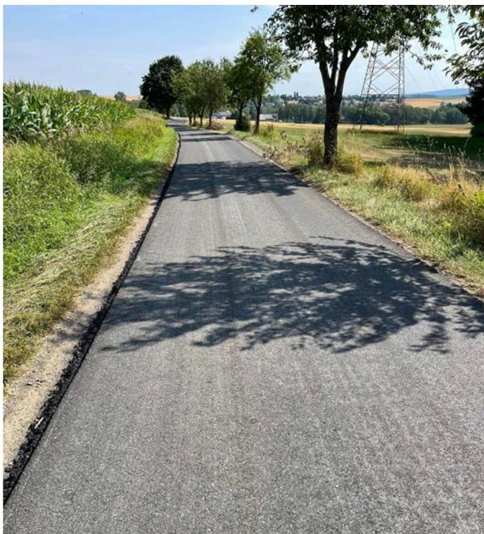
Für rund 25.000 Euro hat die Gemeinde Weißdorf einen Teilabschnitt des Mechlenreuther Weges saniert. Die Arbeiten wurden von der Firma Luding ausgeführt. Die Maßnahme war notwendig, da auf diesem Abschnitt die Seitenränder der Fahrbahn massiv beschädigt und teilweise nicht mehr vorhanden waren, sodass ein bloßes Ausbessern nicht mehr möglich war.
